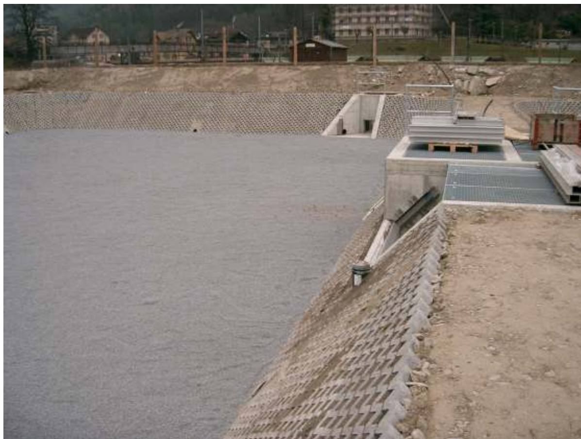
Bild: Zeolithfilterschicht in der Straßenabwasserbehandlungsanlage. © Roland Schwengeler 20
